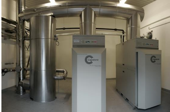
2 Mikrogasturbinen a 65 kW el
